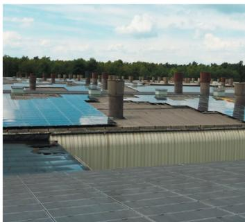
QLEEN hat sich bei schwierigsten Einsätzen bewährt. Diese sehr große Anlage mit einem Neigungswinkel von nur 12 Grad ist neben der Witterung den Ausdünstungen des Mastbetriebes über die Schornsteine ausgesetzt. Es bilden sich sehr schnell klebrige Schmutzfilme, so dass in kurzen Intervallen gereinigt werden muss. Trotz hohem Pflege-Einsatz - die Rendite stimmt.
